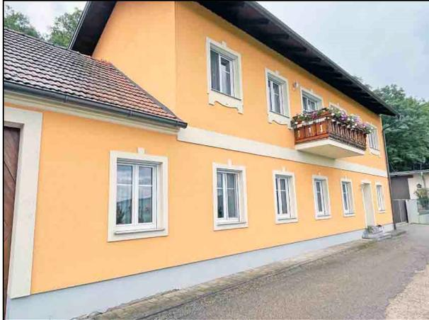
Abb.5: rissfreie Fassade (östliches Gebäude)
